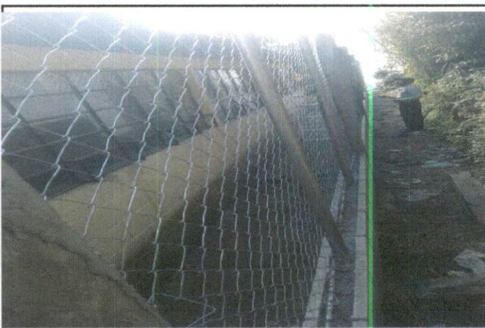
Foto 3: En el lado oeste se puede observar como quedó el muro o cerco perimetral.
