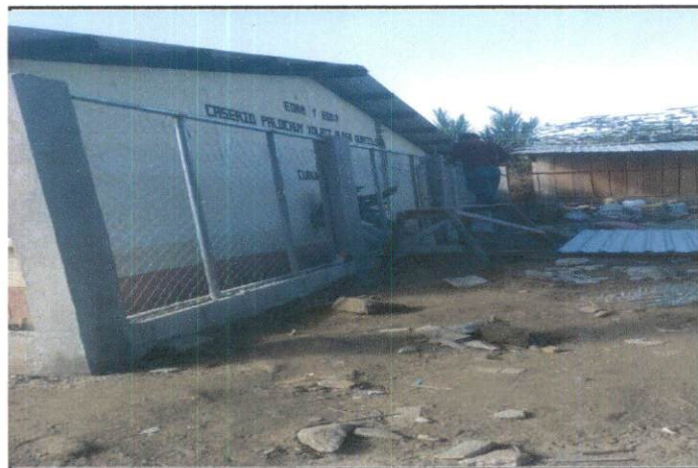
Foto 4: Se evidencia en la parte norte del establecimiento con el muro o cerco perimetral.
