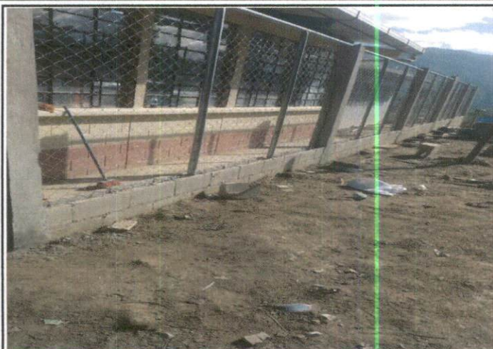
Foto 1: Se muestra el lado este del establecimiento con muro o cerco perimetral.
